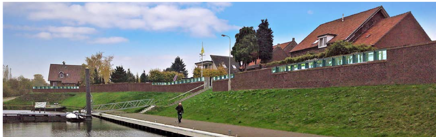
Figuur 4 - Fotomontage van de glazen waterkering in Neer.
